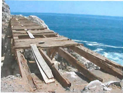
Puente Pabellón de Pica
