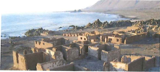
Panorámica vestiglos campamento industrial Huanillos
